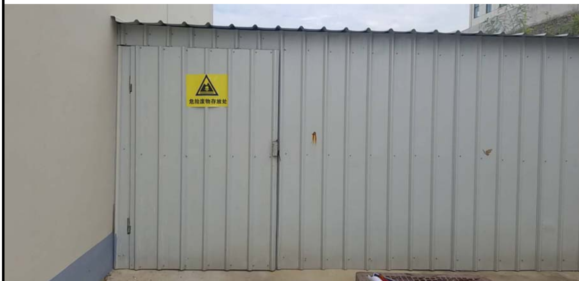
图 3-4 危险废物暂存间
