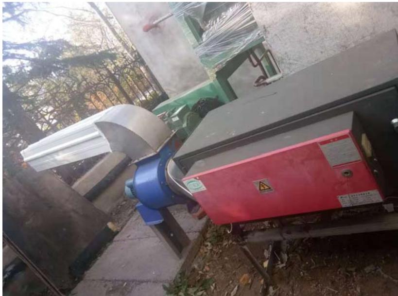
图 3-2 油烟净化装置
